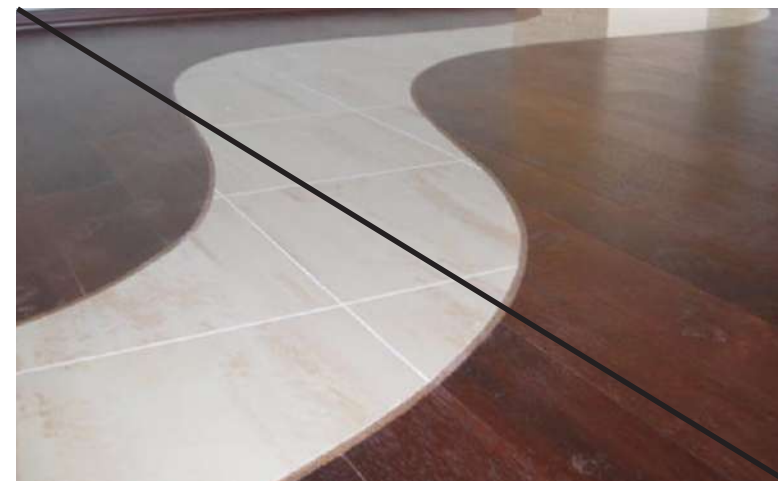
Плохо Узорные стыки из разных материалов
